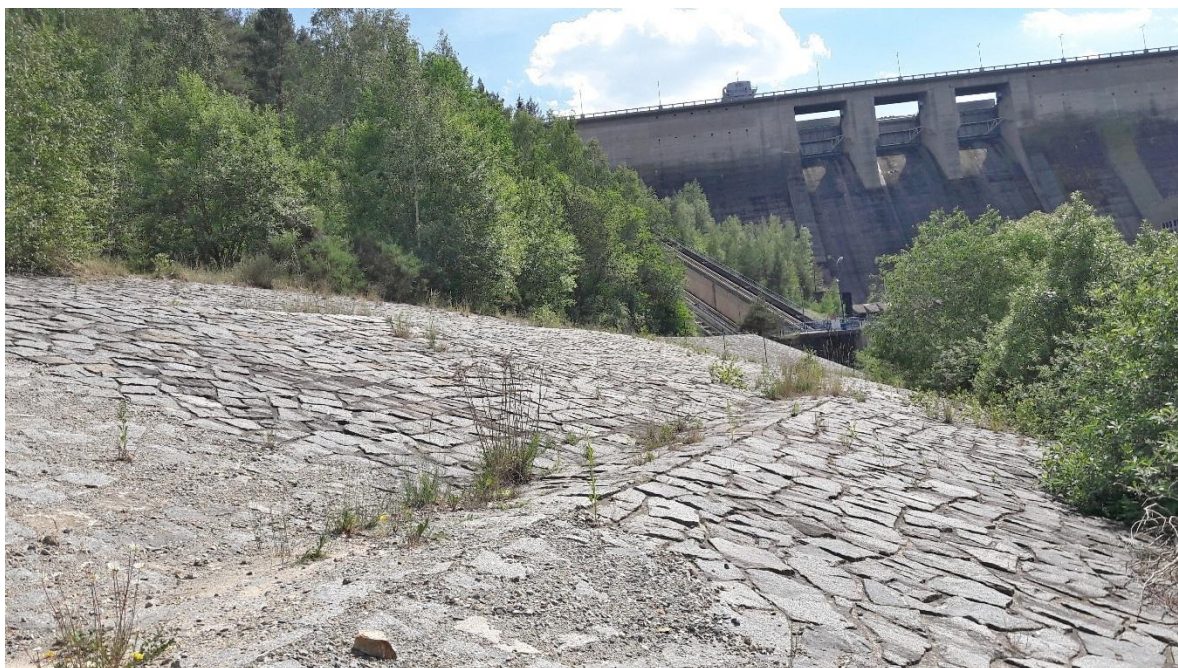
Obr.1 – Pohled na stávající opevnění pravého břehu horního konce vzduť VD Kamýk
